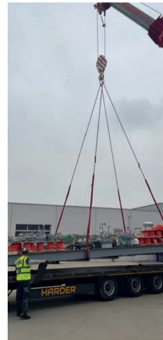
Zum Einsatz kommen auch Schwerlastkräne.
