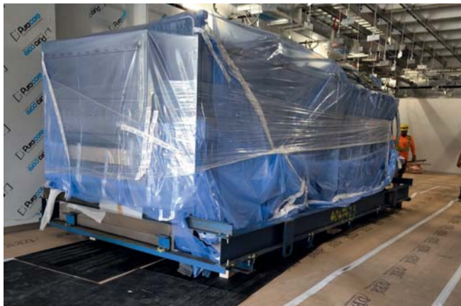
Die einzelnen Bauteile sind teils tonnenschwer.
