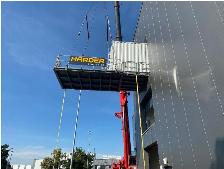
Bildunterschrift: Das Serverraummodul wird mit Hilfe der Montageplattform durch die 3,5 m enge Fassadenöffnung eingebracht. Fotonachweis: EPS
