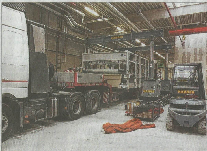
Eine schwere Fertigungsstraße wird von einem Spezial-LKW gehoben und genau positioniert. Fotos: Harder
